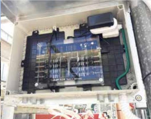
Installation extérieure de Vulcan S250 : sur le toit, profitant du soleil la plupart de l'année. La température à cette période se situait entre 38 °C et 40 °C. L'hiver, la météo est pluvieuse et le boîtier de protection doit être étanchéifié (IP 68). Les bandes à courant d'impulsion de Vulcan étaient parfaitement enveloppées et l'appareil Vulcan installé dans le coffret extérieur.
