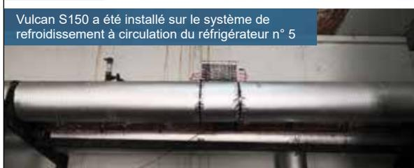
Vulcan S150 a été installé sur le système de refroidissement à circulation du réfrigérateur n° 5
