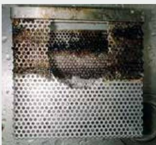
Le panier après avoir été nettoyé à l'aide d'un tuyau souple. Les sections de tuyaux qui sont généralement en contact avec l'eau traitée se nettoient en laissant couler l'eau du robinet.
