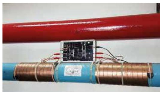
Le dispositif anti-calcaire électronique Vulcan S25 installé
