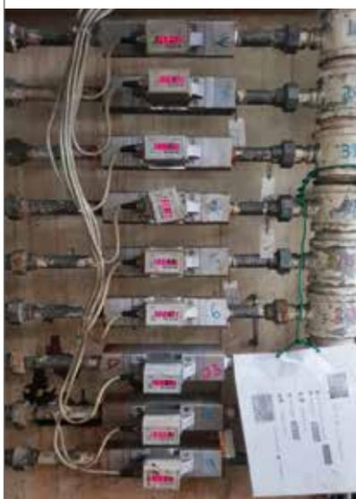
Il existe 9 petites conduites secondaires équipées de compteurs d'eau. Ces compteurs ont été installés pour s'assurer de la stabilité du débit. Le ralentissement du débit pourrait poser un problème au niveau de la machine de trempe par induction. Cela explique pourquoi les conduites devaient être nettoyées manuellement tous les 2 à 3 mois.
