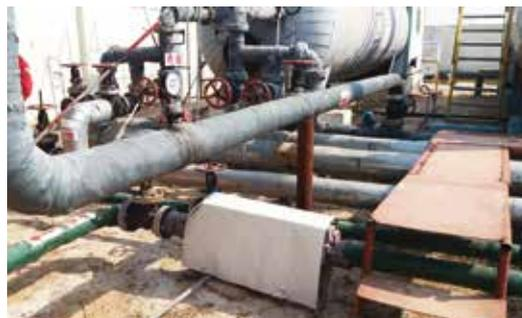
Installation à l'extérieur avec couvercle fait maison, pour protéger l'appareil du vent et du soleil.
