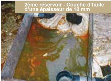
2ème réservoir - Couche d'huile d'une épaisseur de 10 mm
